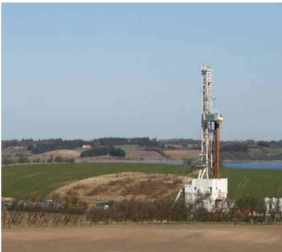
Den nye risikoafdækningsordningen er en frivillig ordning for økonomisk risikoafdækning i forbindelse med geotermiboringer.
