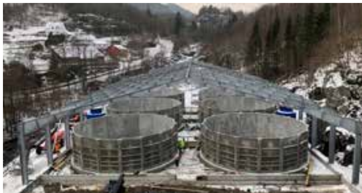
Anlegget: Fra byggingen av anlegget. Bildet er tatt i januar. Foto: Reidar Våge/Mowi
