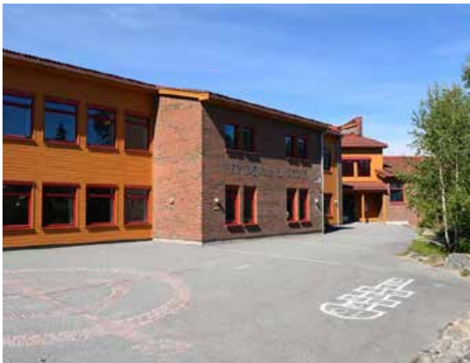
Frydenlund skole i Røyken gikk fra oppvarming med el. kjele til CO 2 -varmepumper, med 22 brønner på 300 meter og med en energigevinst på 38 prosent.
