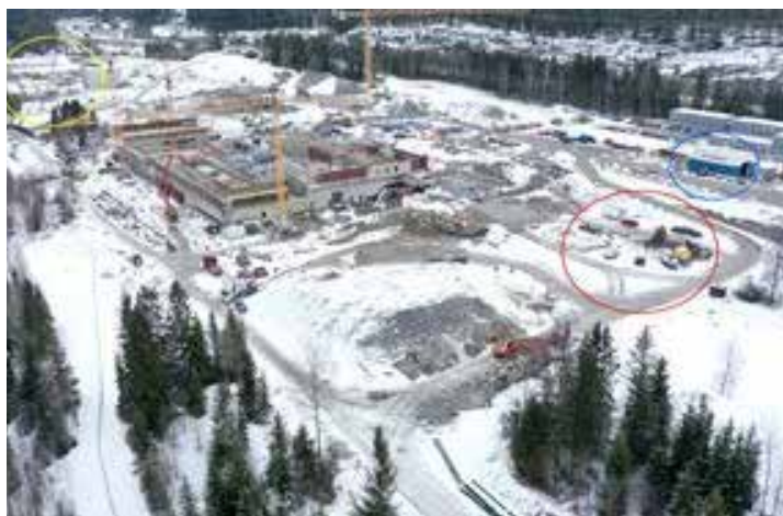
Politiets nasjonale beredskapssenter: Bilde over fremdriften i begynnelsen av mars 2019. Den røde ringen markerer stedet der det bores 1500 meter dype brønner. Den blå ringen markerer landingsplass og oppstilling for helikoptre. Den gule markerer hvor utendørs og innendørs skytebaner skal ligge.
