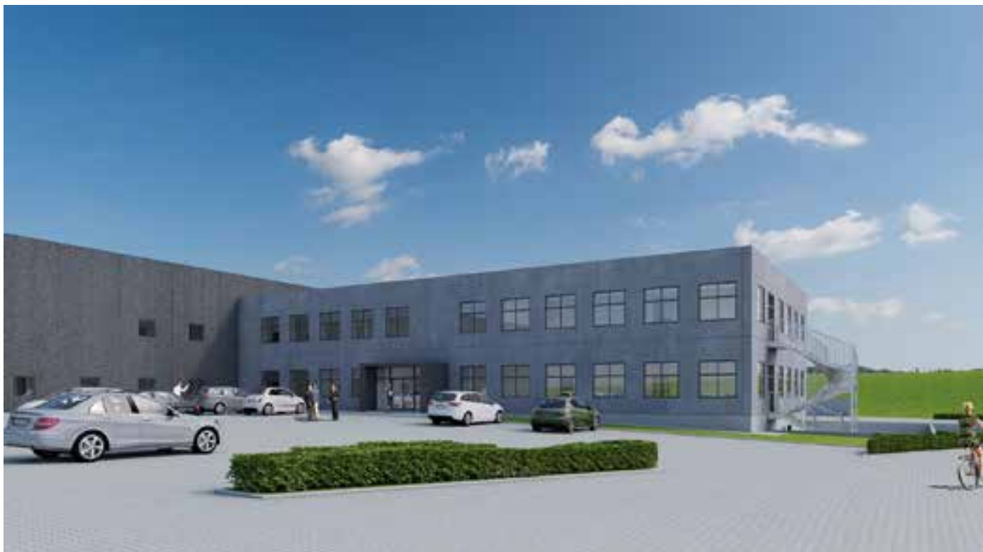
Advansors nye hovedsæde og produktionshal bliver i alt 10.000 kvadratmeter stort og vil fordoble produktionskapaciteten. Byggeriet skal stå færdigt i slutningen af 2019.
